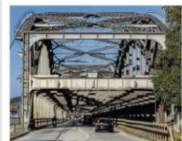
1915 begonnen, 1926 vollendet: die Freifahnelbrücke. FOTO: RAUHE
